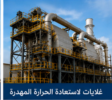
مولدات البخار لاستعادة الحرارة (HRSG)
